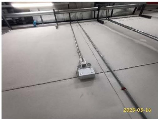
ระบบไฟฟ้าส่องสว่างสำรอง
